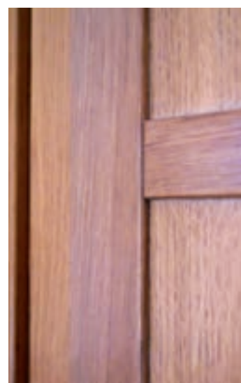
particolare traversa "Genova" su scuretto interno
