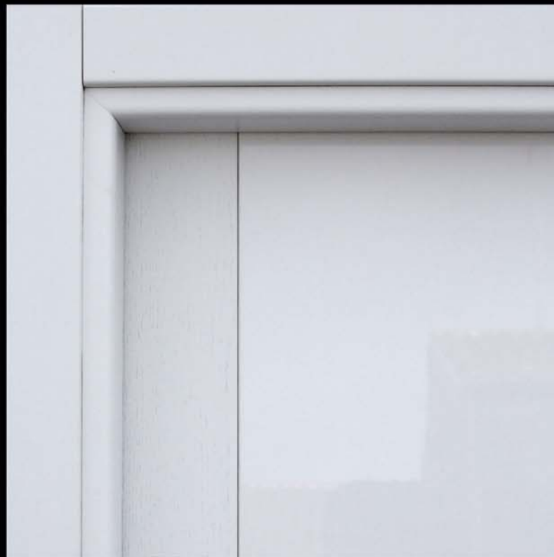
Particolare Telaio e coprifili Opachi
